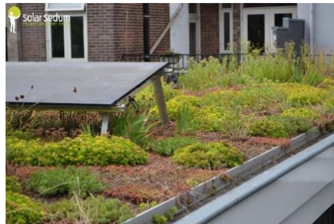
Zonnepanelen (ook icm groen dak)
