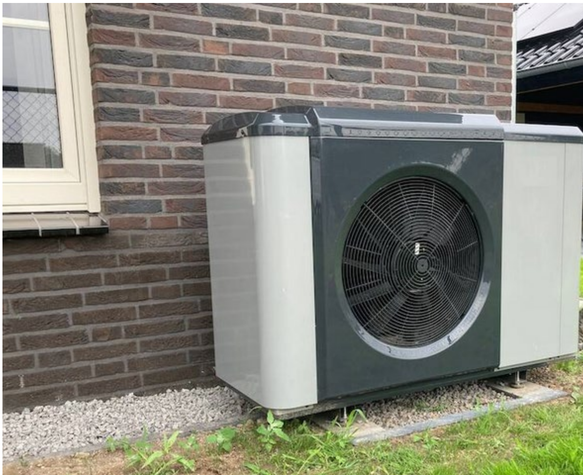
Figuur 31: Opstelling van een monoblock warmtepomp (Bron: Wolf Energiesystemen)
