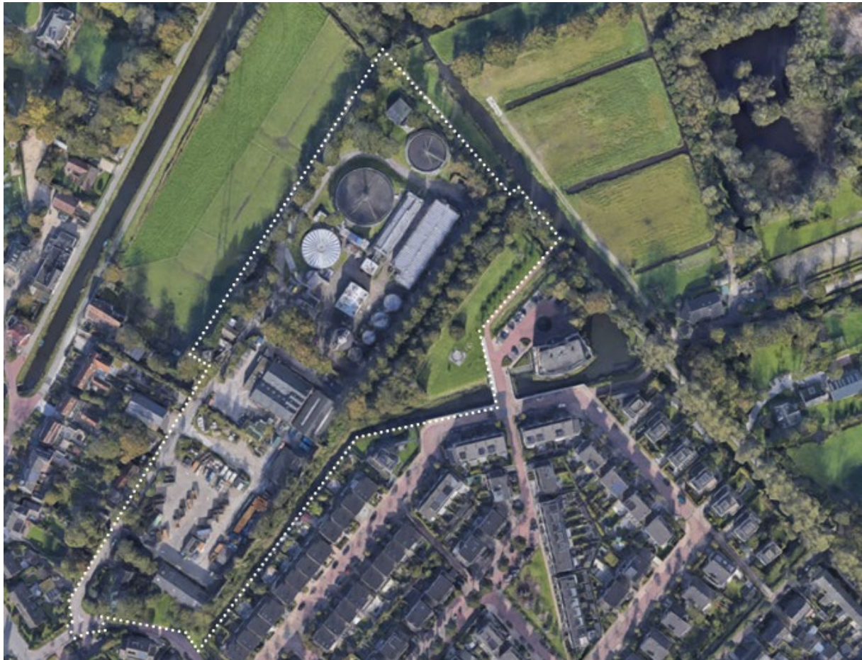
Figuur 2: De voormalige RWZI Maarssen. Het terrein heeft als nieuwe bestemming wonen.
